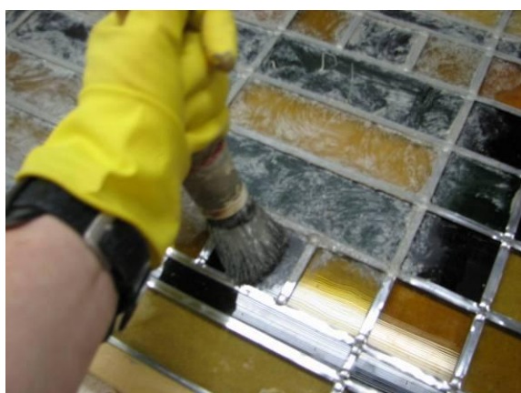
Figuur 9: kitten (wind- en waterdicht maken)
