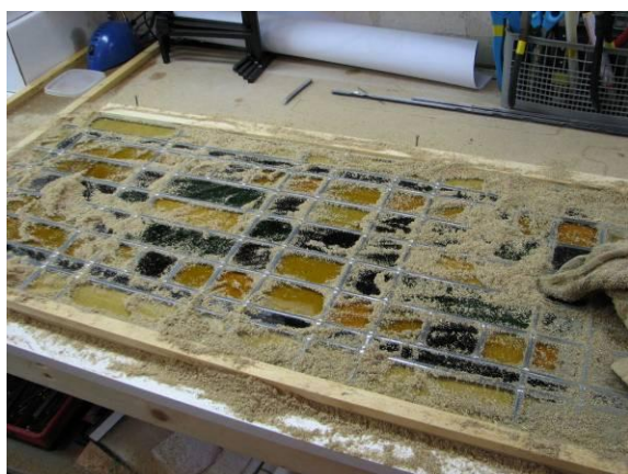
Figuur 13: ook hier de kit verwijderen (van alle ruim 110 stukjes glas...)
