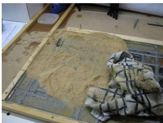
Figuur 11: kit verwijderen met zaagsel
